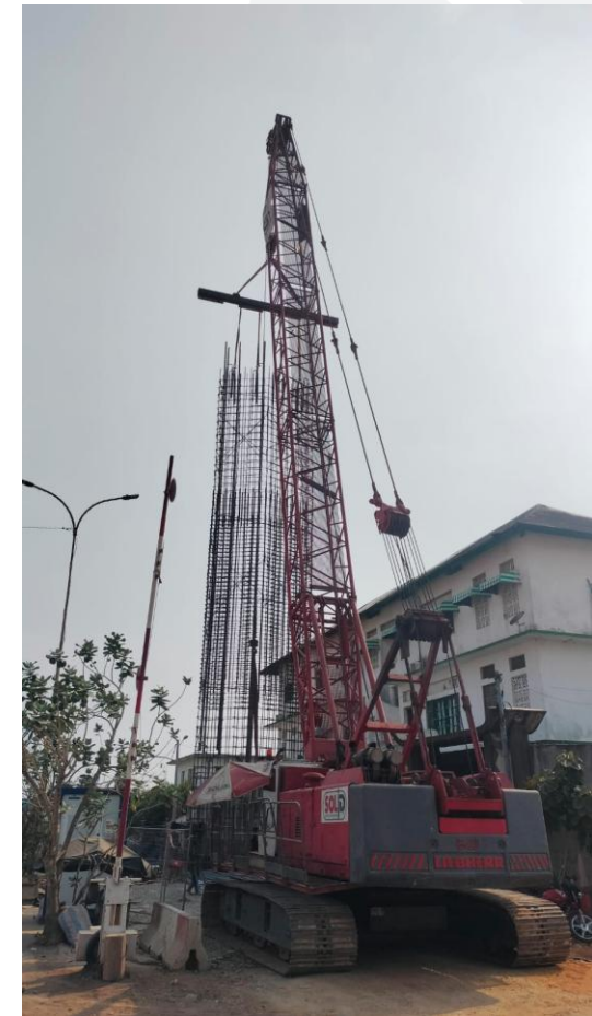
Benne et grue de service atelier parois moulées
