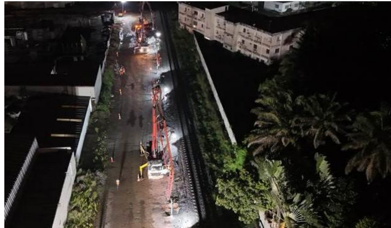
Coulage de nuit, comblement de la DN 1800 existante
