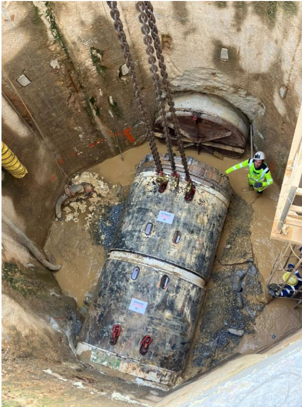
Phase n°1 de sortie dans un puits diamètre 6m
