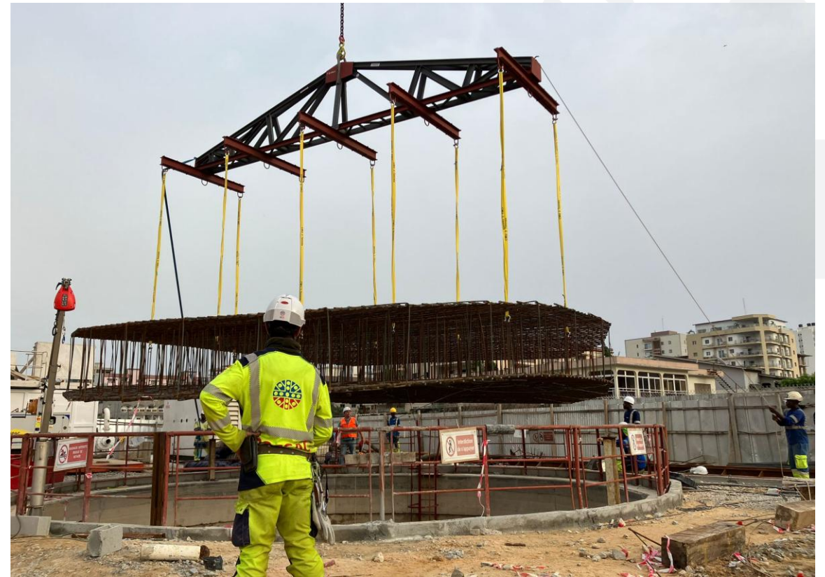
Mise en place du ferrailage du radier définitif après assèchement du puits
