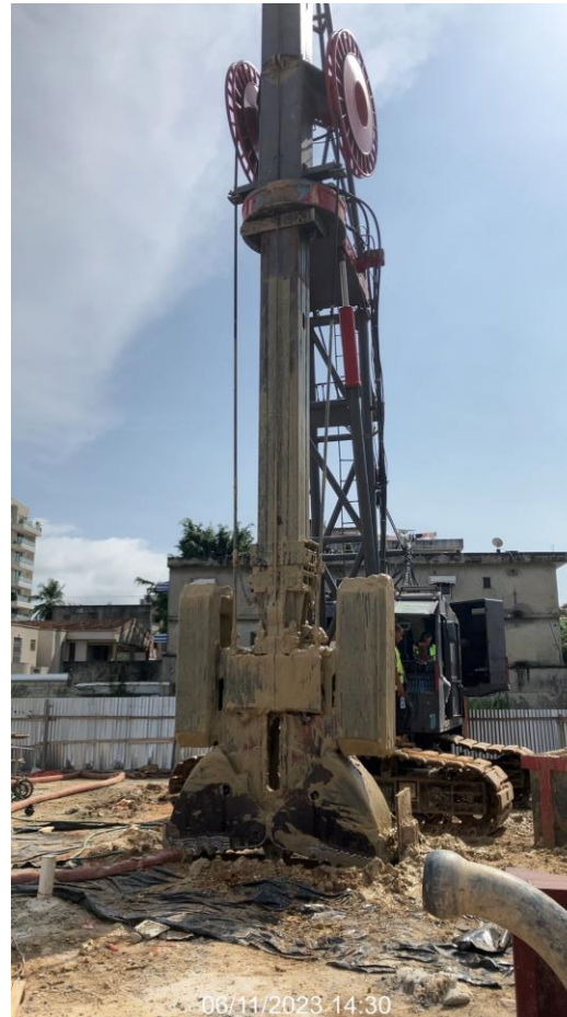
Benne et grue de service atelier parois moulées
