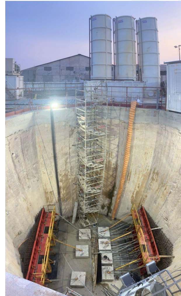
Coffrage des murs tympan et de poussée et installation de la STP en surface
