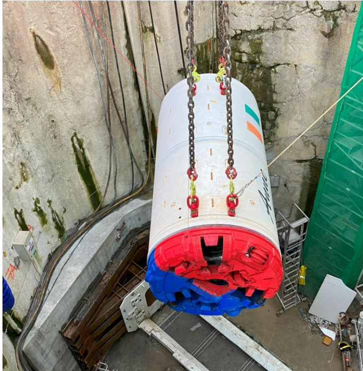
Descente du micro-tunnelier
