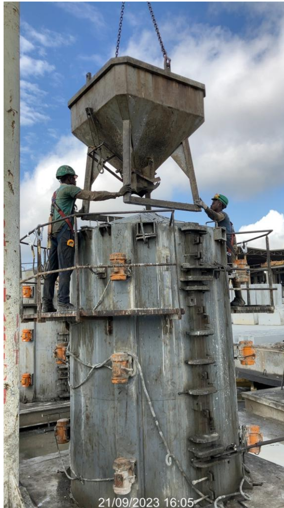
Coulage d'un tuyau
