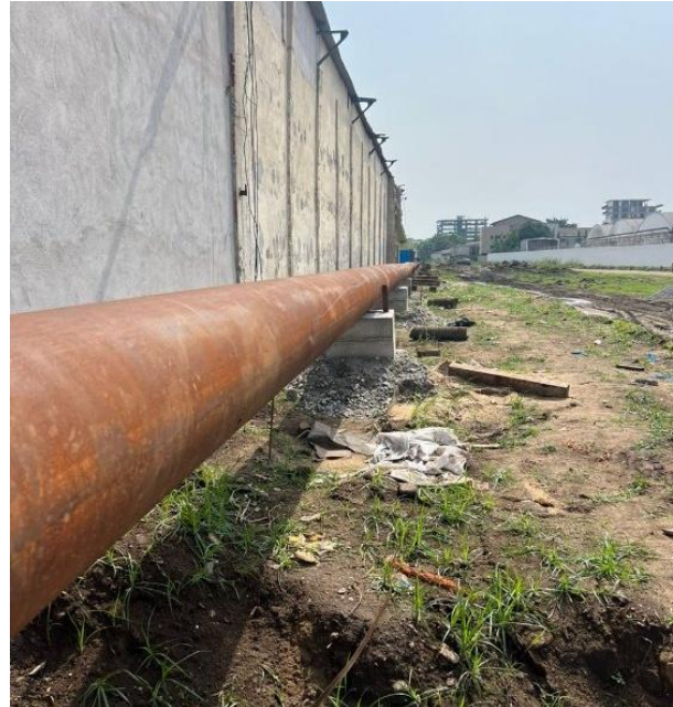
Conduite DN 400 et chambre d'interception de la conduite existante
