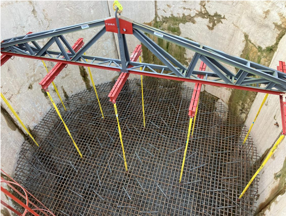
Mise en place du ferrailage du radier définitif après assèchement du puits
