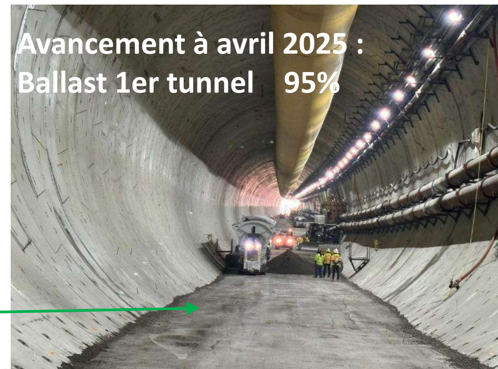
Travaux de remplissage en ballast niveau 1
