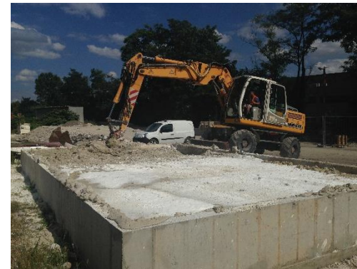
Déblais de parois moulées
