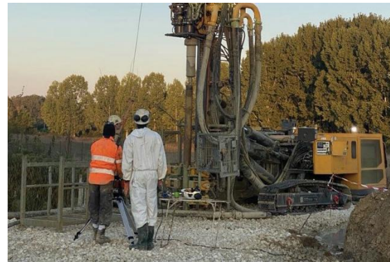
Coulis de forage
