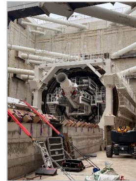
Etape 4 : Montage du bâti de poussée
