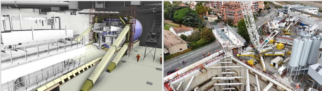
Etape 6 : Excavation de 165ml de tunnel avec marinage à la pompe TAP et montage associé des remorques R3 à R8
