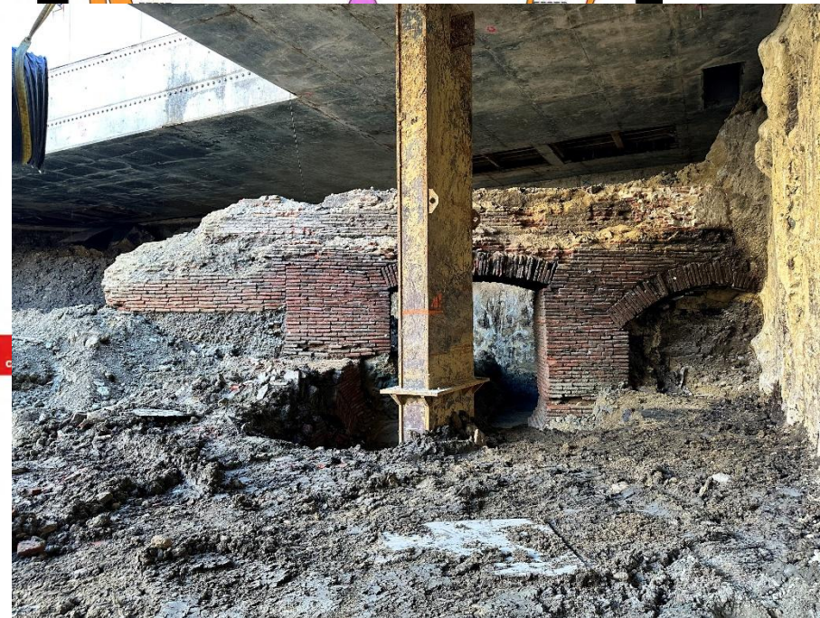
Aqueduc et mur de contrescarpe (janvier 2025)
