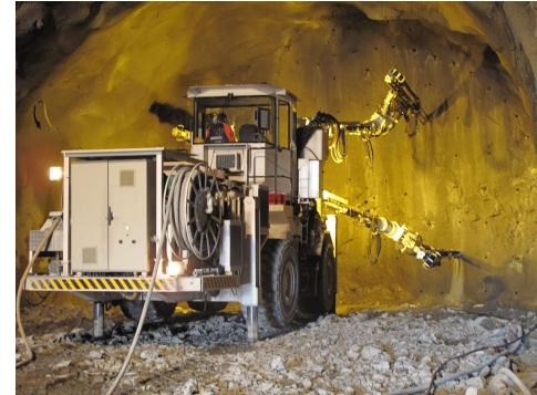
Utilisation d'un Jumbo de foration manuel, semi automatisé ou automatisé à 1, 2, 3 ou (4 bras) de foration
