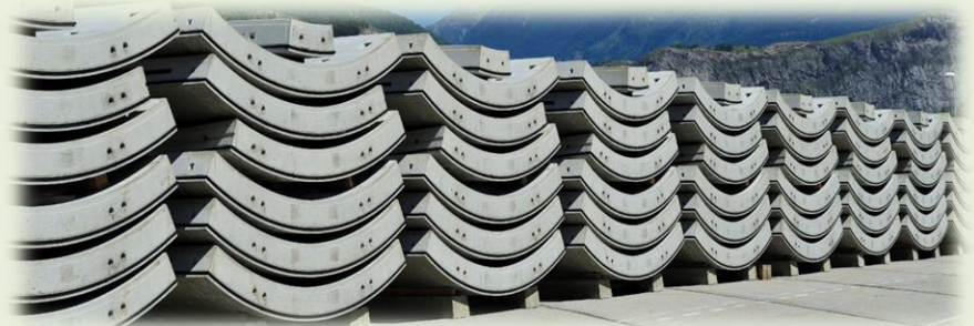
Stockage des voussoirs sur l'aire du Rieu-Sec
