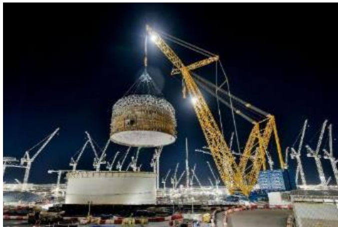
Pose d'un rondau de liner du bâtiment réacteur à l'aide de Big Carl (plus grosse grue du monde)
