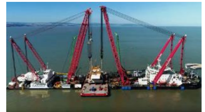
Transport et pose d'une tête de prise d'eau
