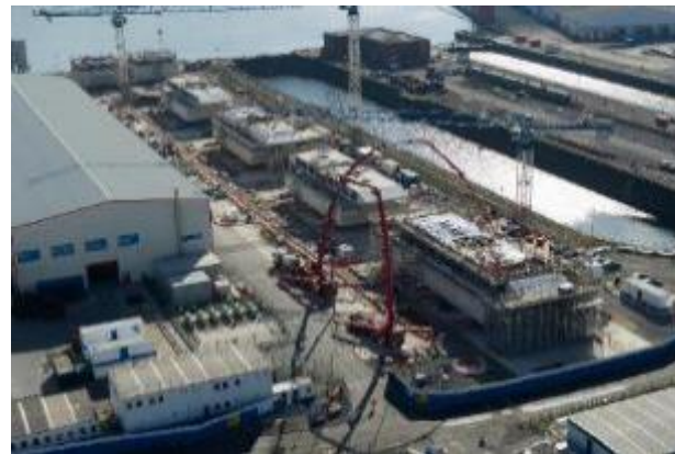
Aire de préfabrication des têtes
