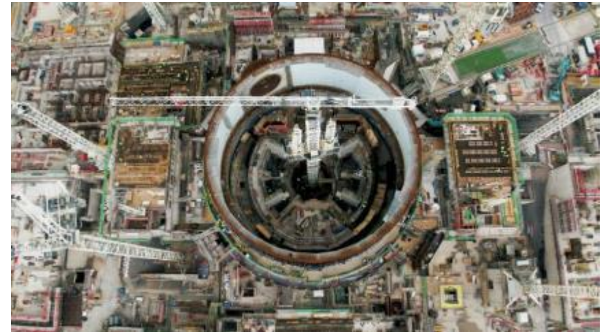
Vue de l'avancement du bâtiment réacteur et des bâtiments avoisinants
