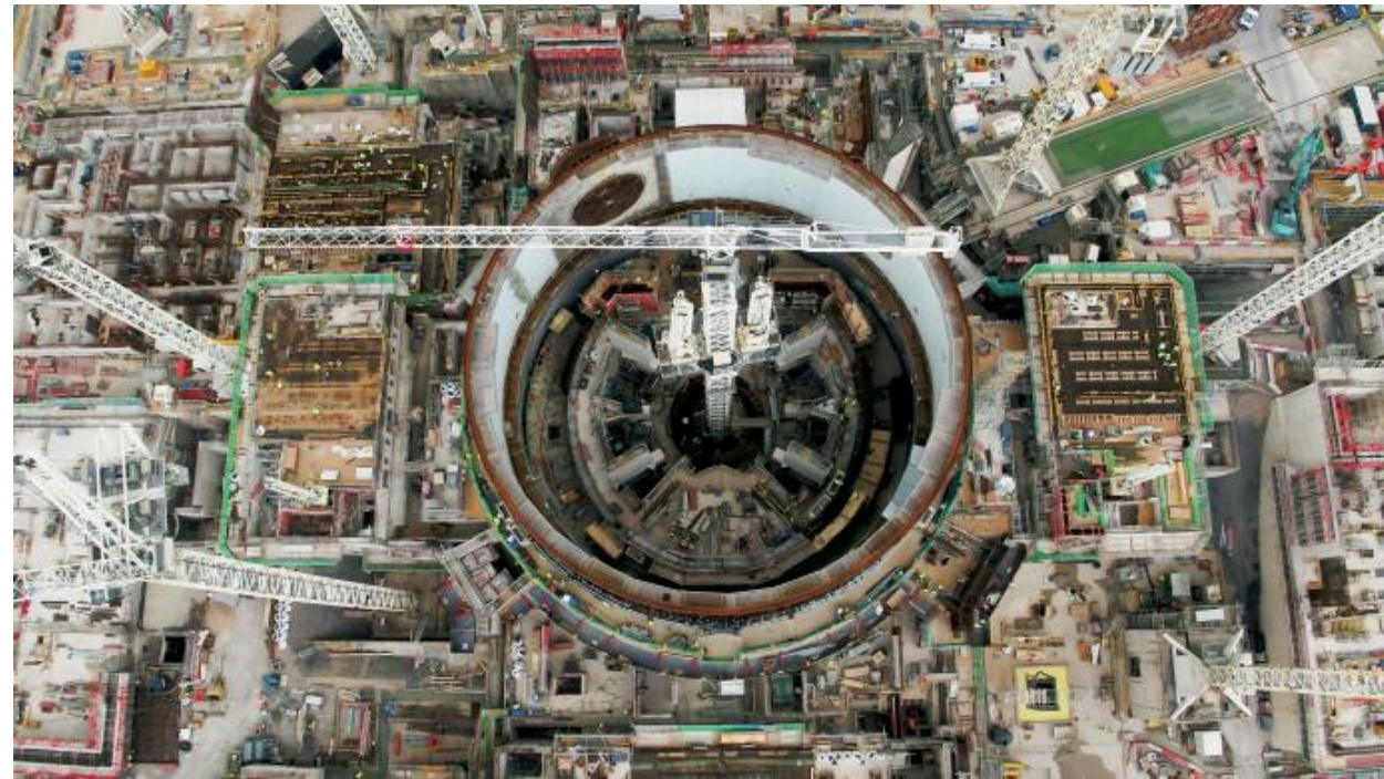
Vue de l'avancement du bâtiment réacteur et des bâtiments avoisinants
