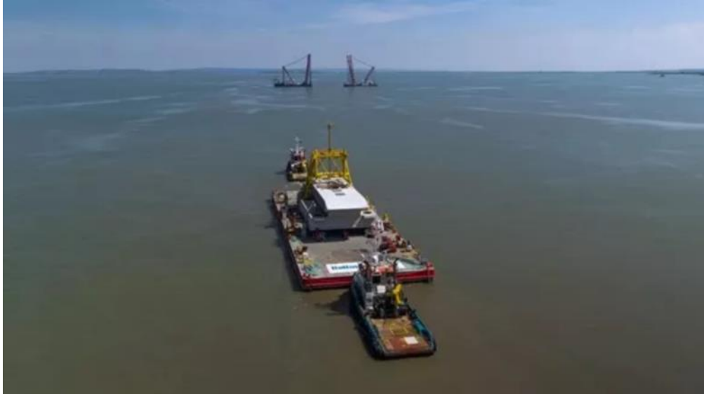
Transport d'une tête de prise d'eau
