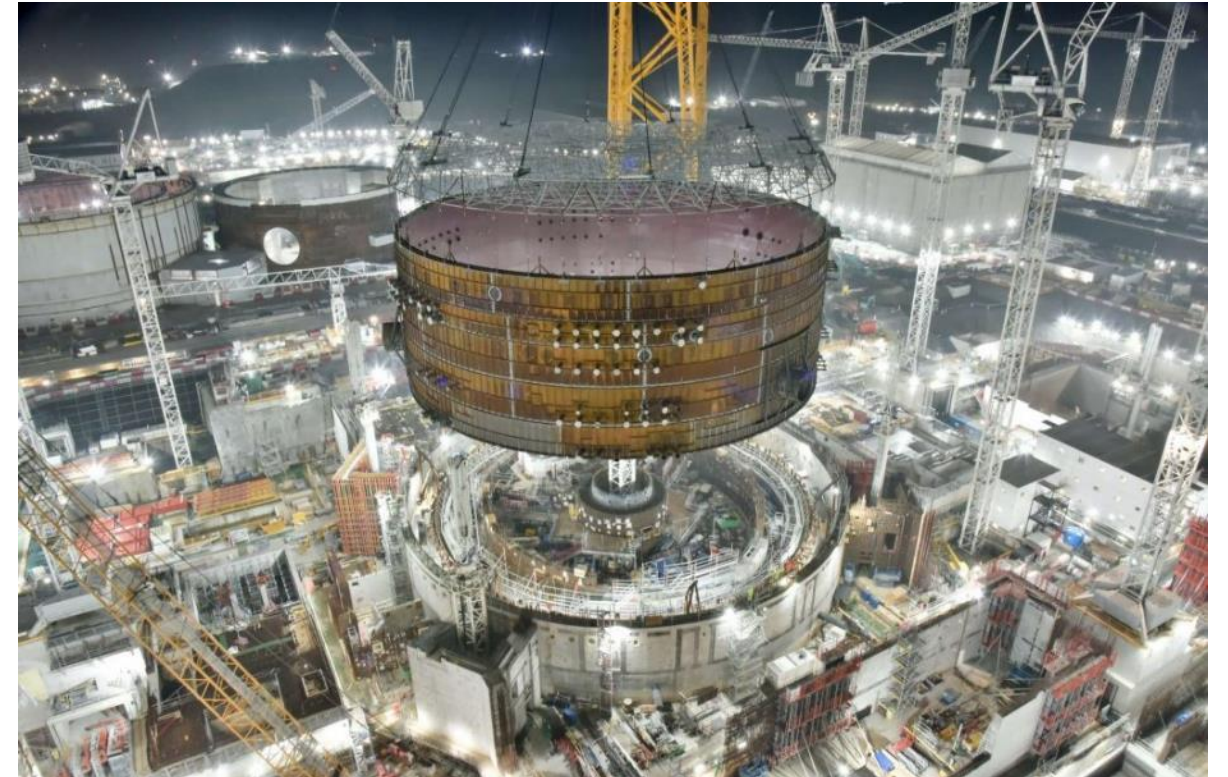
Pose d'un rondau de liner du bâtiment réacteur à l'aide de Big Carl (plus grosse grue du monde)
