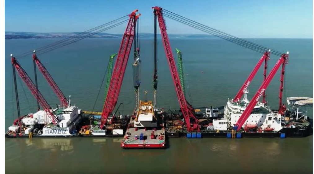
Pose d'une tête de prise d'eau
