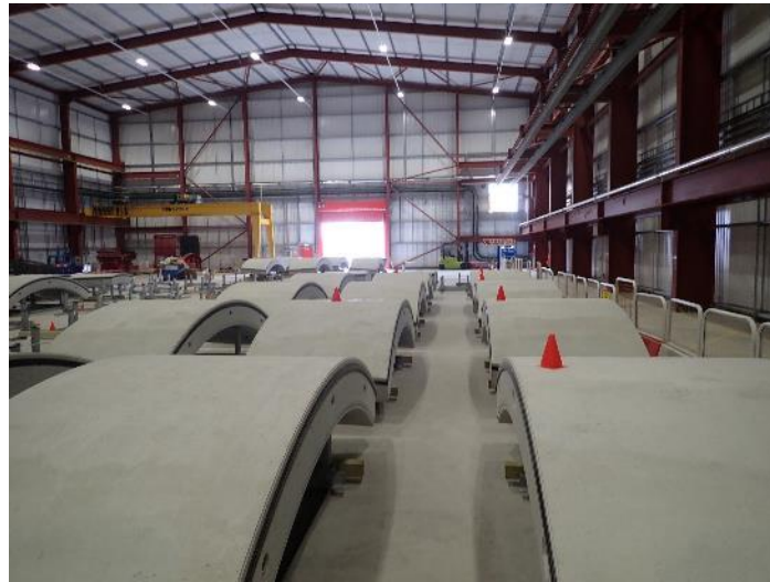
Préfabrication des voussoirs sur le port d'Avonmouth
