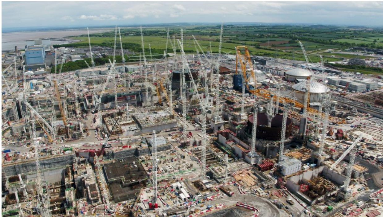
Vue de la cinquantaine de grues sur le chantier
