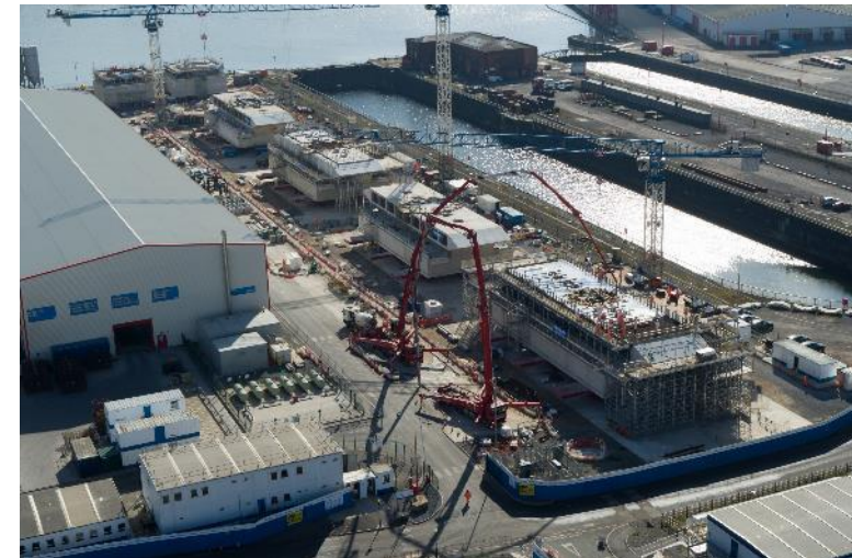
Aire de préfabrication des têtes
