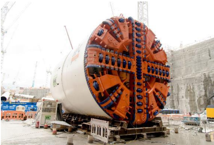
Tunnelier à pression de terre
