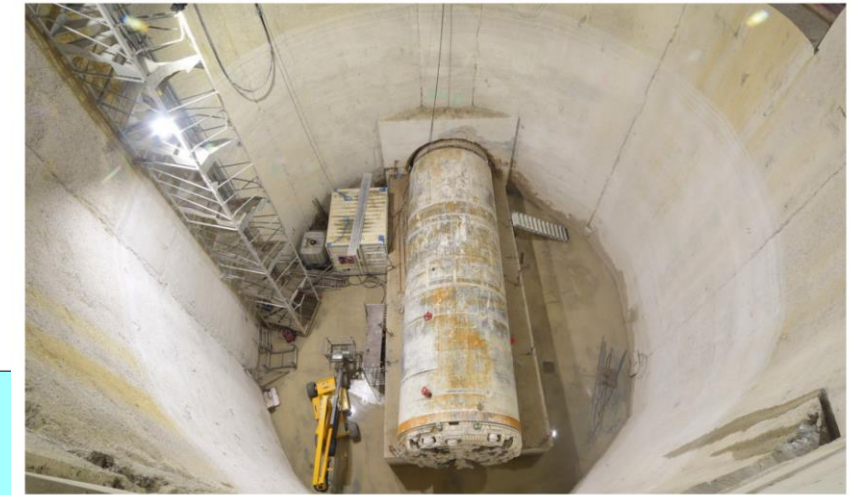
Figure 18 : Tunnelier en fond de puits Briche - TBM at the bottom of the Briche shaft
