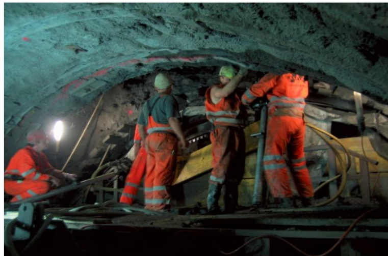
Tunnel de base du Gothard, dégagement d'un TBM bloqué
