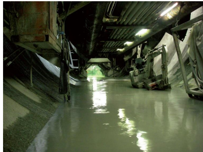
Tunnel de base du Gothard, température eau 43°C
