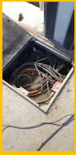
Humidité au fond des chambres et caniveaux
