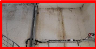
Fissure sous face infiltrée
