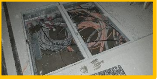
Humidité au fond des chambres et caniveaux
