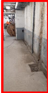
Fissure sous face infiltrée
