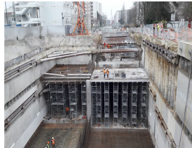
Etape 3 Bétonnage de la couverture puis remblaiement jusqu'au niveau de la voirie.
