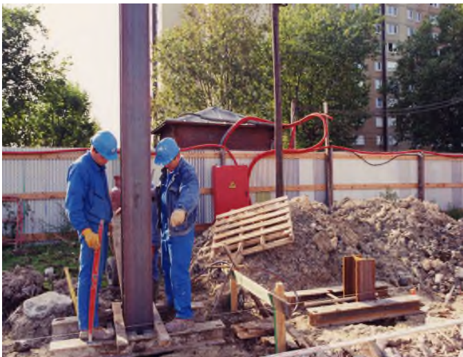
Etape 1 Pose de parois protectrices et creusement de la tranchée.
