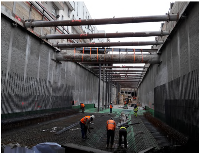
Etape 2 Bétonnage de la dalle et des parois verticales.
