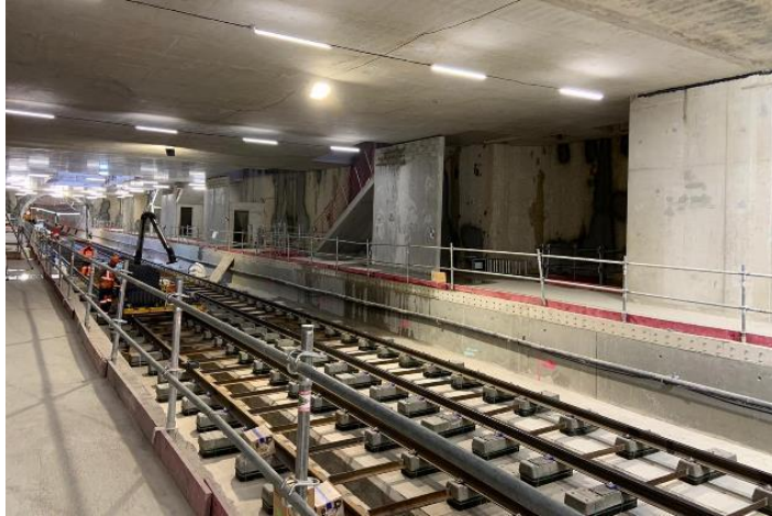
Volume des quais, pose de la voie
