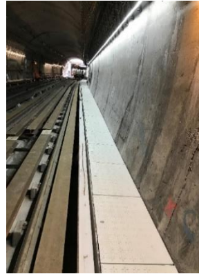
Travaux de pose de la voie en cours
