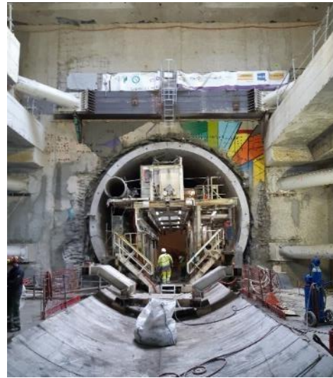
Démontage tunnelier Allison
