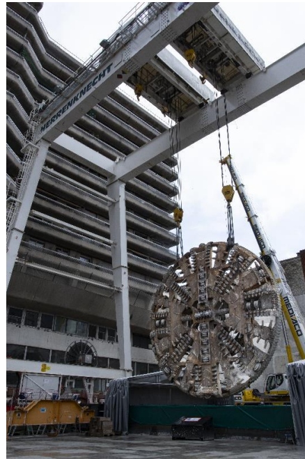
Démontage tunnelier Allison
