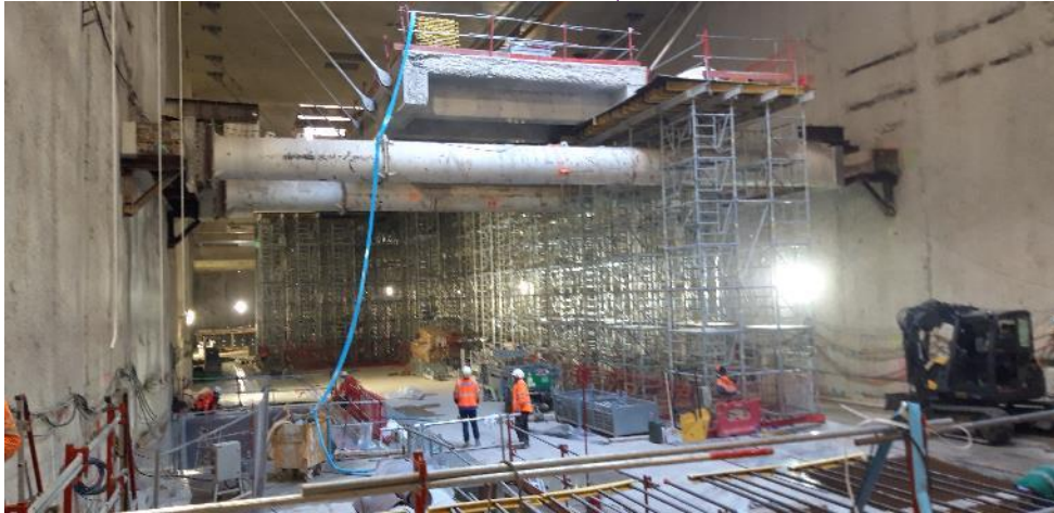
Désétalement passerelle nord
