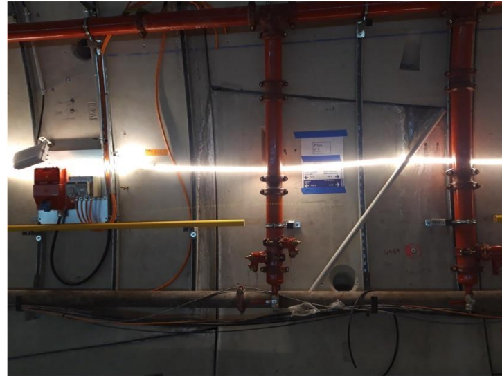
Déploiement Equipements de Sécurité en cours (Colonne sèche, main courante, prise Générphone)
