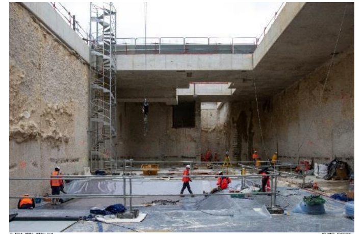
Travaux d'étanchéité niveau -1
