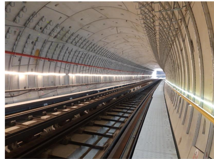
Déploiement Equipements de Sécurité en cours (Colonne sèche, main courante, prise Générphone)
