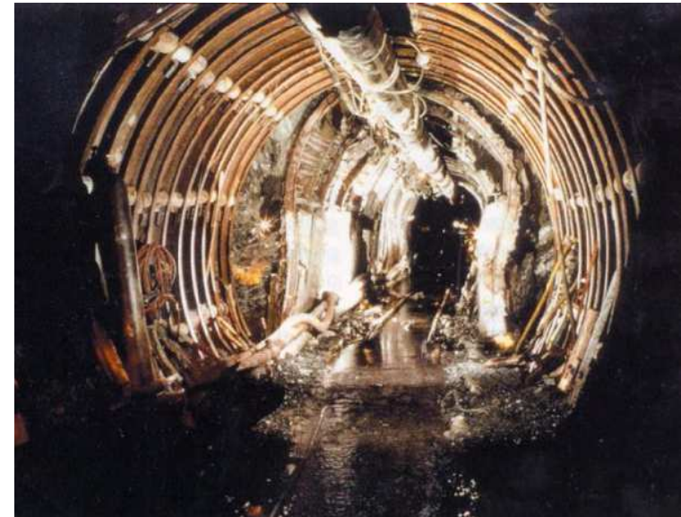
Comportement ductile associé à de la plasticité en cisaillement
