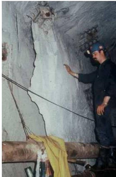
Comportement fragile associé à de la fissuration d'extension
